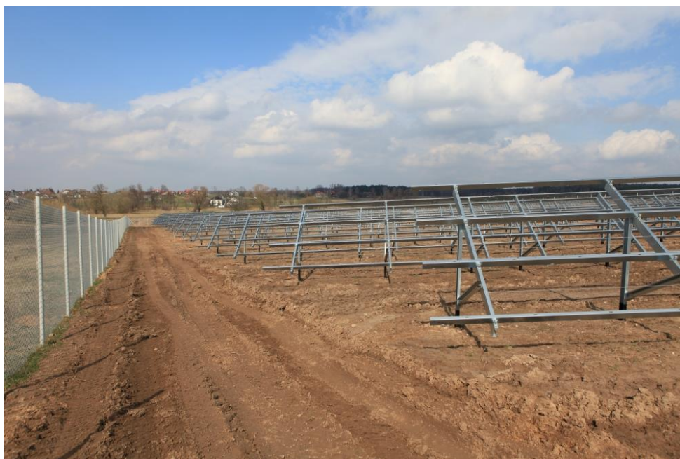
Przykładowa instalacja gruntowa
